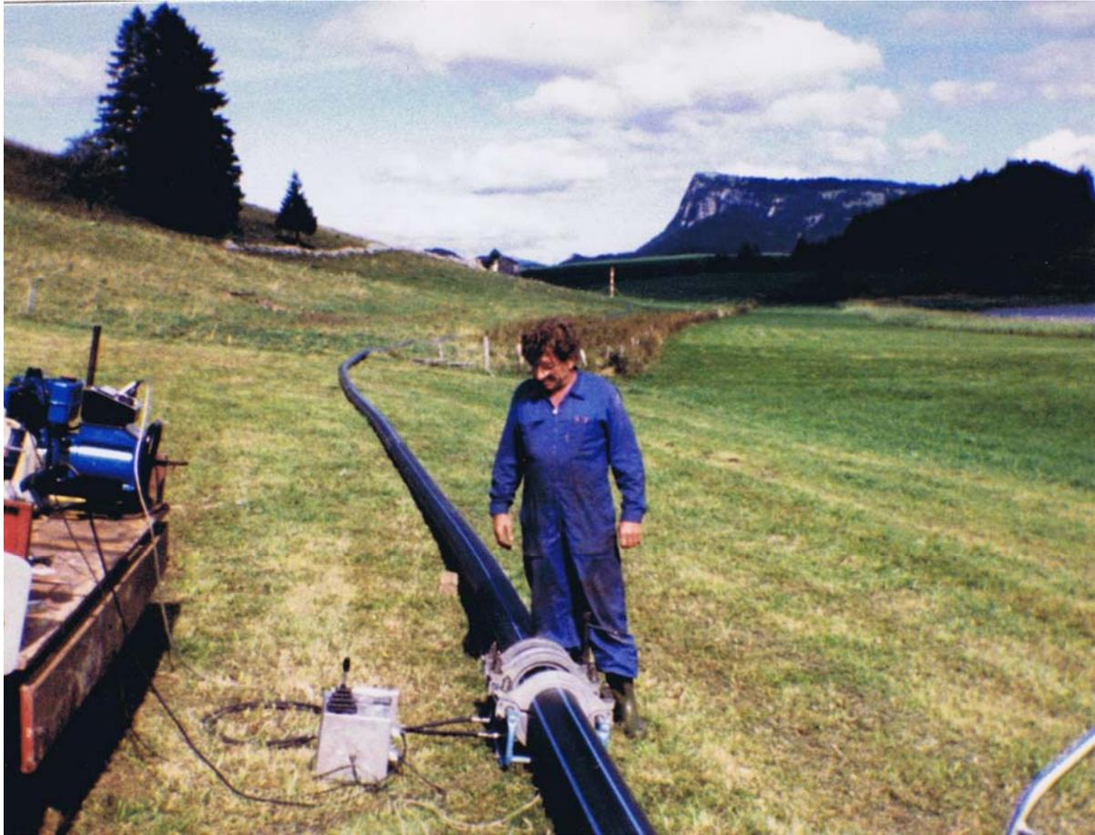
Sur le vaste chantier de la mise en terre du tuyau d'eau potable reliant les trois communes de la Vallée. Ici sur les bords du lac Ter.
